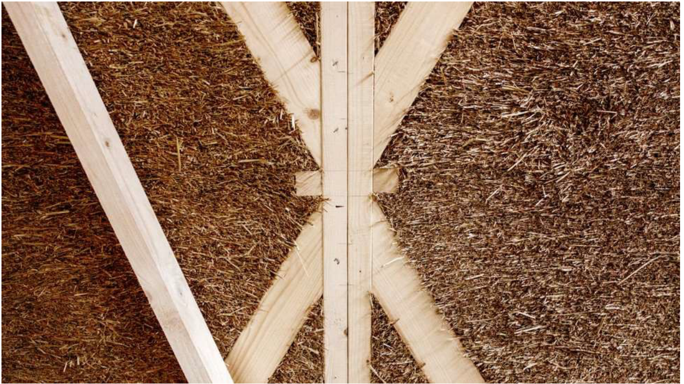
Halm bruges som isolering. Foto: Henrik Bo
